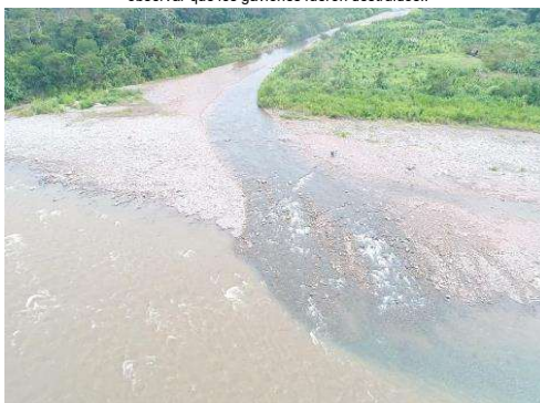
Fotografía 3: Sector confluencia con el Río Ubriki, se observa que la Margen derecha la infraestructura de gaviones se encuentra afectada (caídos), debido al cambio de curso de agua por el material que traslado el Río Ubriki.
